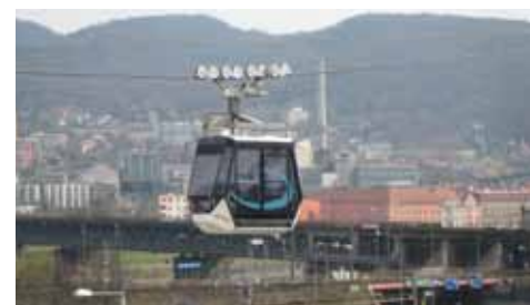
37 • Pendelbahn Vetruse, Tschechien
