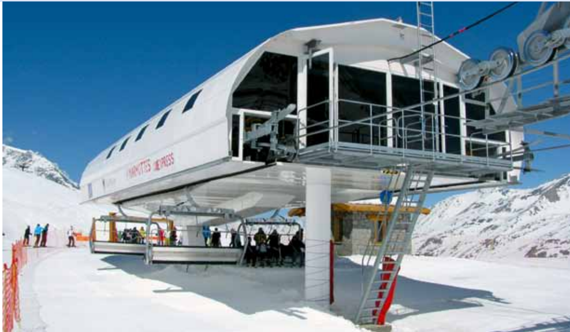
25 • Talstation kuppelbare 6er-Sesselbahn Les Marmottes in Val d'Isère
