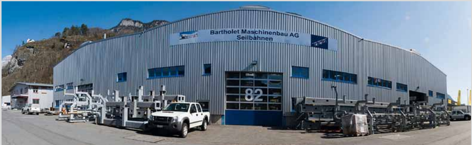
79 • Neu erstellte Montagehalle, 2009
