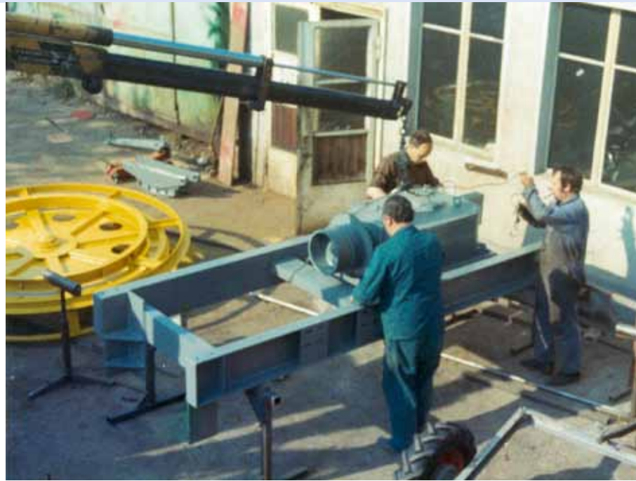
10 • Die engen Platzverhältnisse zwangen die Arbeiter immer wieder zu Montagen im Freien.
