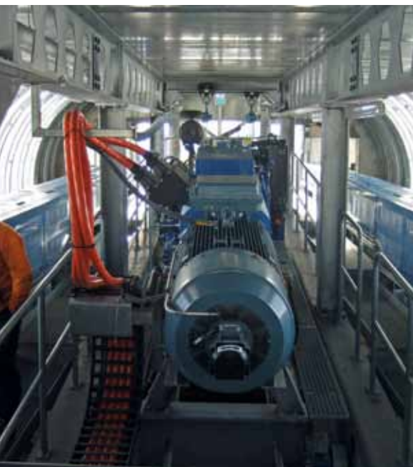
32 • Kompakte Antriebseinheit der Sesselbahn «Bellalui»
