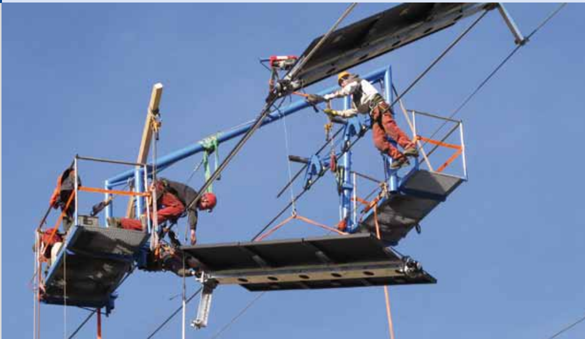
99 • Montage der Solarpanels in luftiger Höhe mit Spezialmontagevorrichtung
