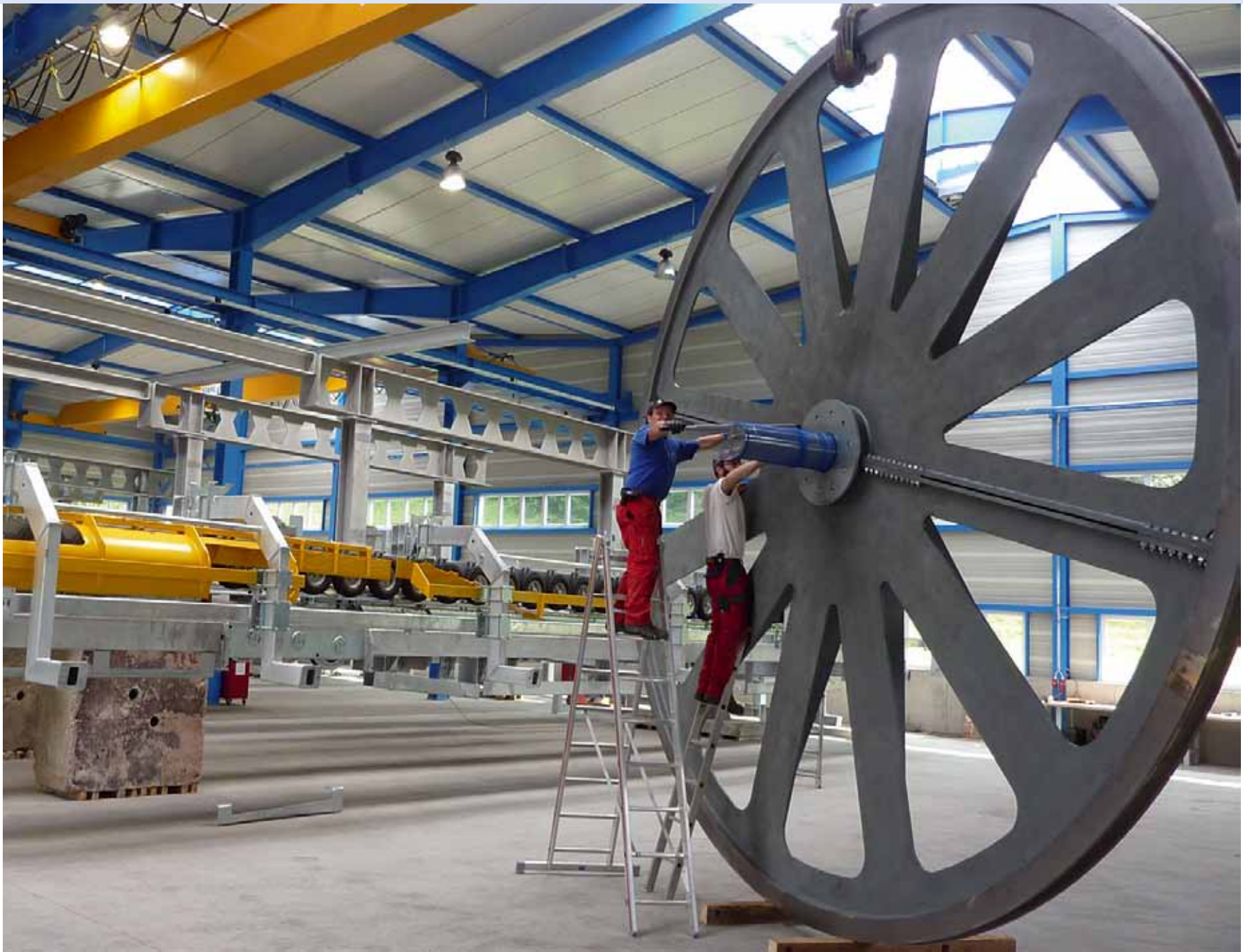
77 • Montage einer zweiteiligen 6-Meter-Umlenkscheibe
