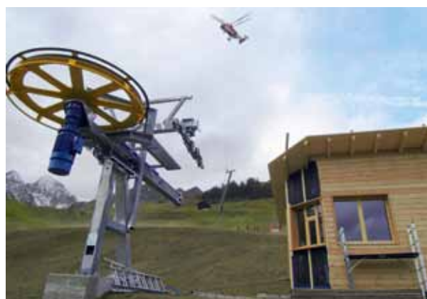
100 • Montageflug einer Skiliftstütze per Schwerlast-Transportheliokopter KA-32 in Tenna
